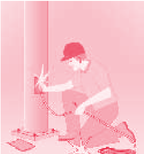
Ο εργαζόμενος έπαθε ηλεκτροπληξία καθώς αφαιρούσε τη μεταλλική ατσαλίνα.
