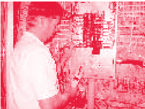
Έλεγχε τα κυκλώματα για να βεβαιωθείς ότι είναι απενεργοποιημένα. Φόρα πάντα τα κατάλληλα ΜΑΠ.
