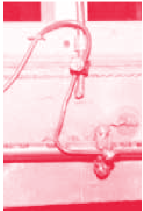
Τοποθέτησε μια συνδετική γέφυρα βραχυκύκλωσης γύρω από μη αγώγιμα υλικά.
